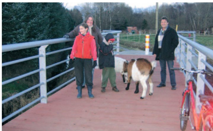
Ortsbürgermeister Wittschieben (rechts) freut sich über die neue Brücke. Auch das Vieh findet wieder ohne Umwege zu seinen Futterplätzen
